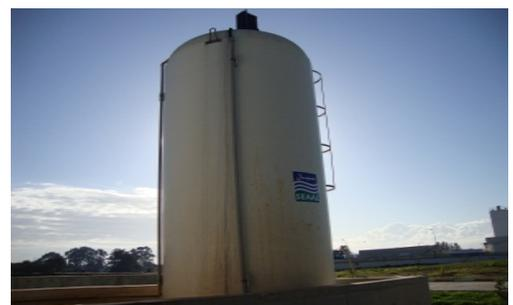
**Figure VI.14:** *cuve de stockage du chlorure ferrique*
