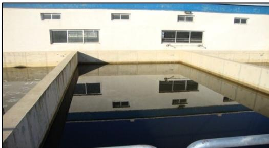
**Figure VI.16 :** filtre plein pendant le fonctionnement
