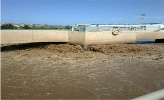
**Figure VI.11 :** *la zone aérée du réacteur biologique (nitrification)*
