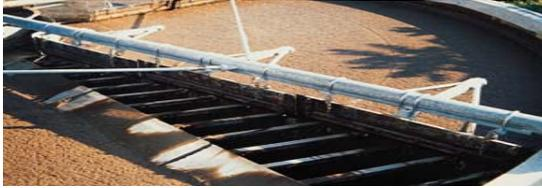
**Figure IV.15 :** Épaississement des boues Par flottation [21]
