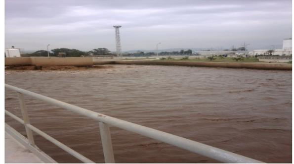
**Figure VI.12 :** *la zone anoxie du réacteur biologique (dénitrification)*
