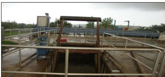
Figure VI.7 Dégrilleur [STEP Réghaia]
