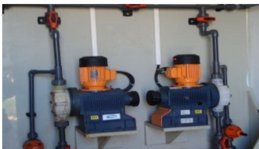
**Figure VI.13:** *pompe doseuse du chlorure ferrique*
