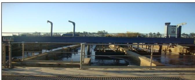
Figure VI.9: Dégraisseur-Dessaleur (STEP de Réghaia) [44]
