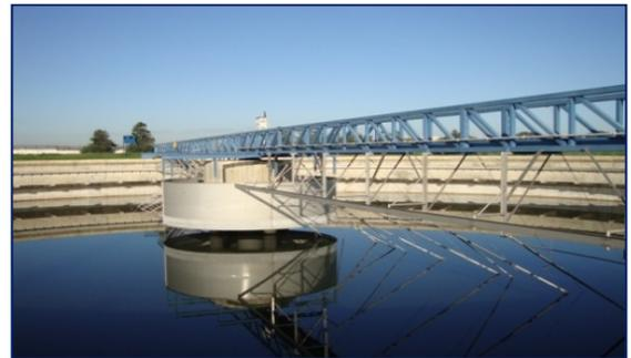
**Figure VI.15:** Clarificateur (Station de Réghaia) [44]
