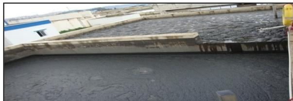
**Figure VI.21 :** *Bâche de stockage des boues* (Station de Réghaia) [44]
