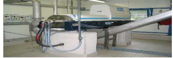
**Figure IV.16:** déshydratation boue par centrifugation [21]
