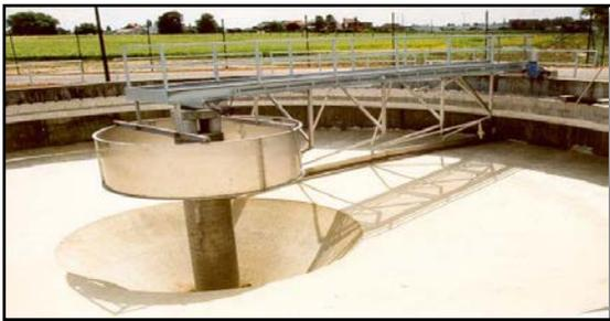
**Figure IV.2:** *Décanteur primaire avec Pont racleur à entraînement périphérique [21]*
