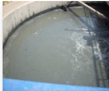
Figure V.7: Photo du déssableur- dégraisseur [STEP Boumerdes]
