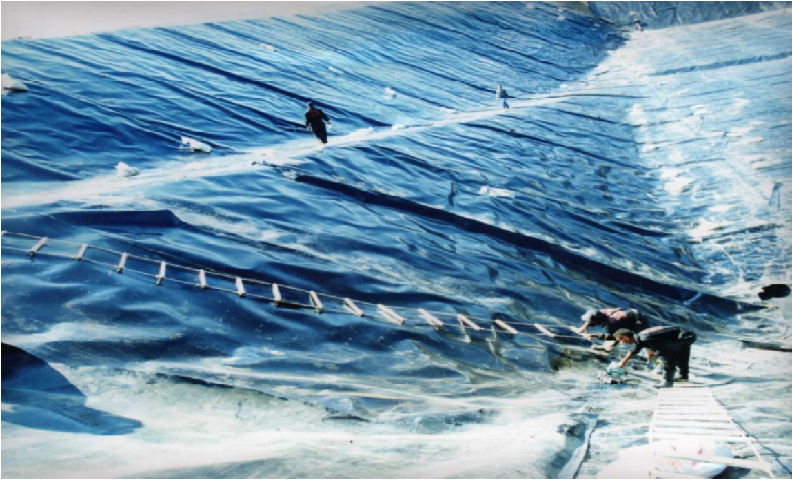
Figure IV.4 : pose et soudure de la géomembrane.
