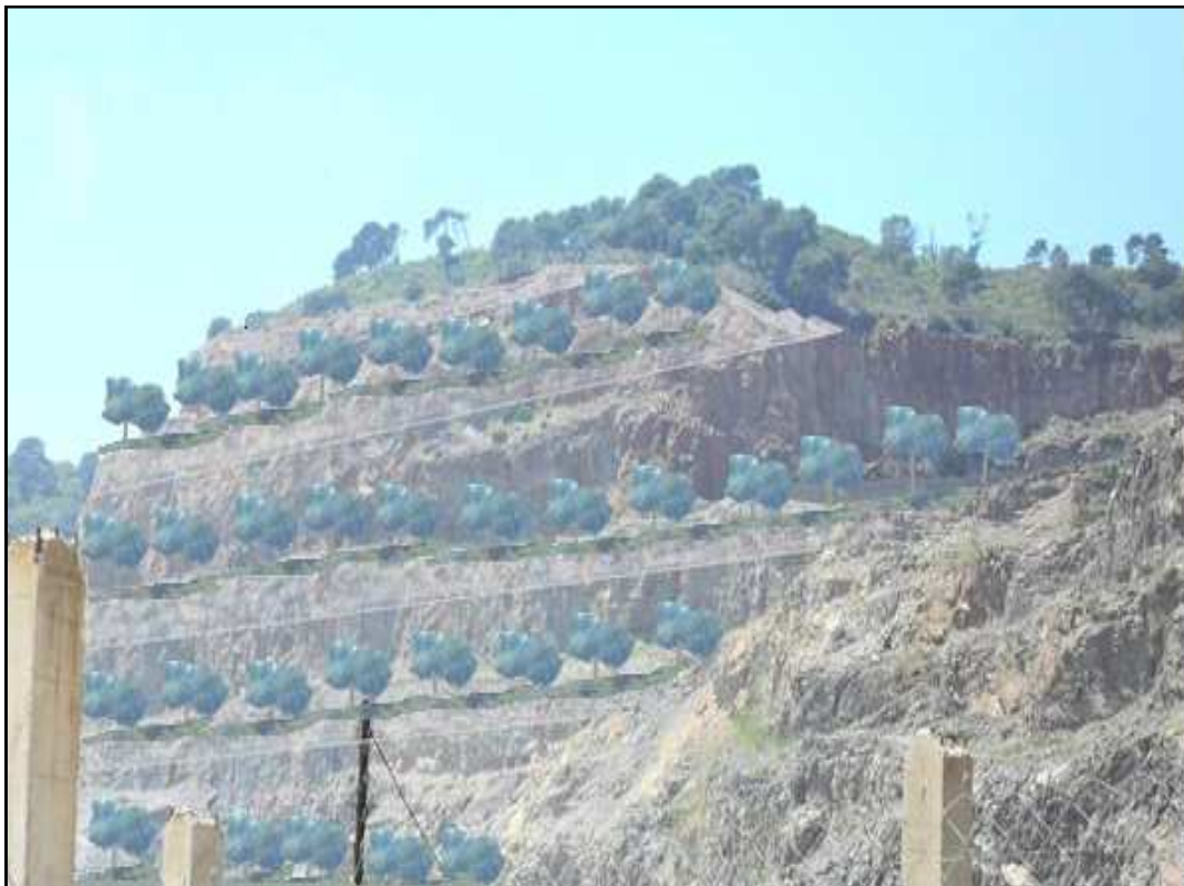
Figure 4.25: Aspect du site Nord après le réaménagement proposé.
