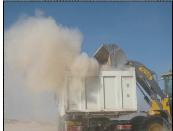
Fig.2.10 : émission de poussière par chargement des camions.
