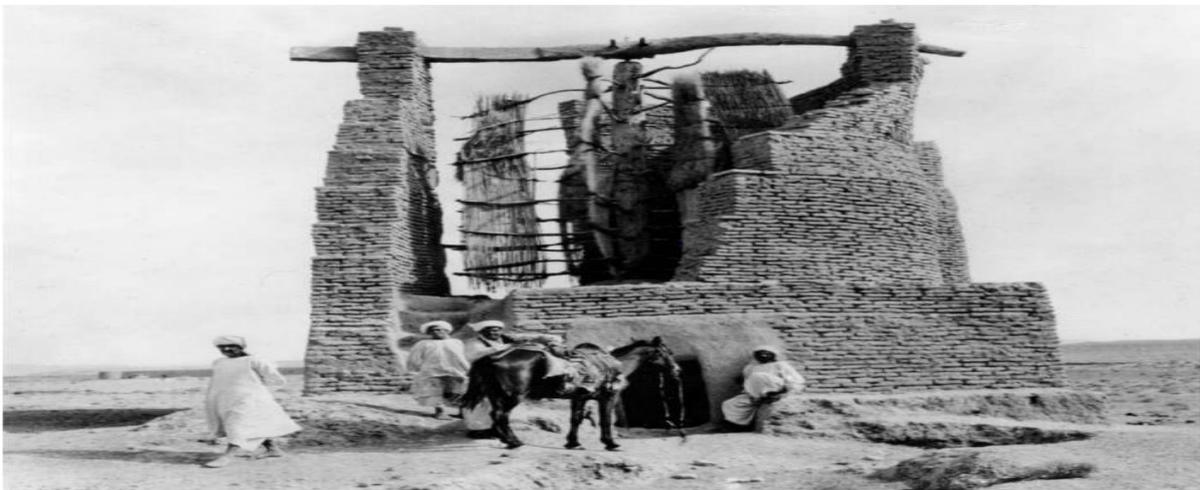
Figure 1-1 : Moulin à vent vertical-axis pour le fraisage du grain, Afghanistan [3]
