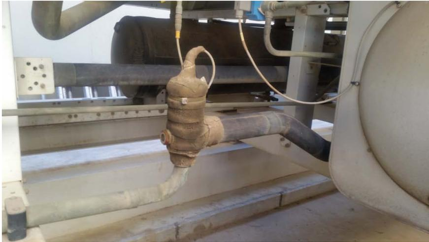
**Fig.2.7** : Module de détente électronique EXV
