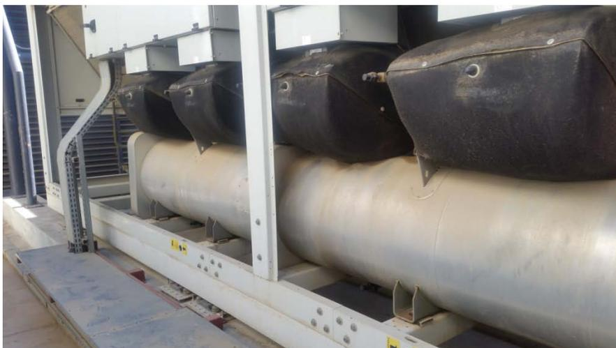
**Fig.2.4 :** Photo des 4 compresseurs et de l'évaporateur.
