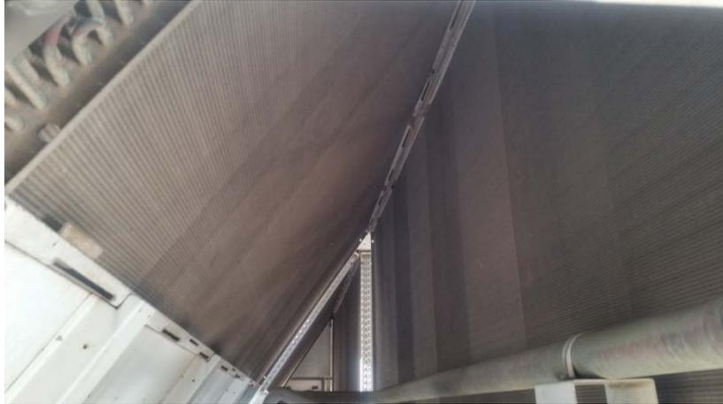
**Fig.2.6 :** Disposition des condenseurs en forme de « V »
