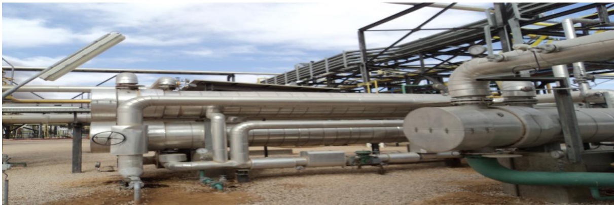
Figure 4 : échangeur à vapeur (DAOUDI H. 213).
