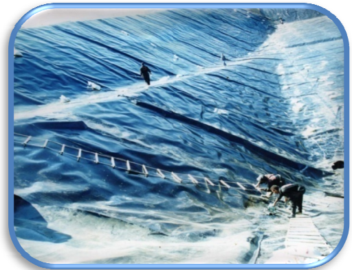
Figure 14: Mise et soudure de la Géomembrane.
