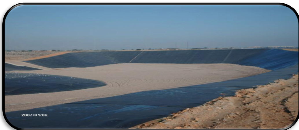
Figure 8: L'État de la Décharge après 2002. (Casier d'enfouissement technique) [49]
