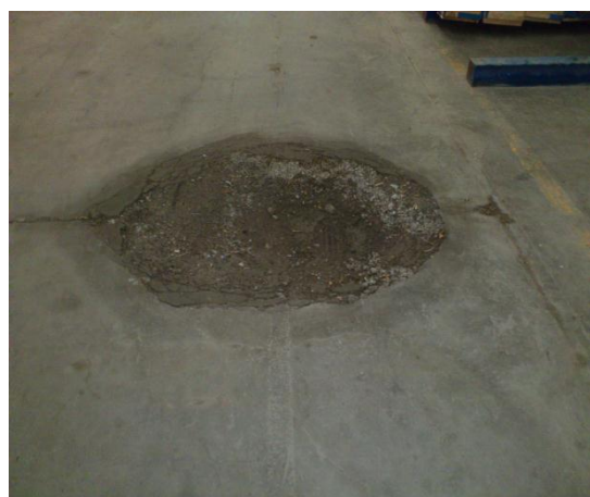
Figure IV. 3 Sol détérioré
