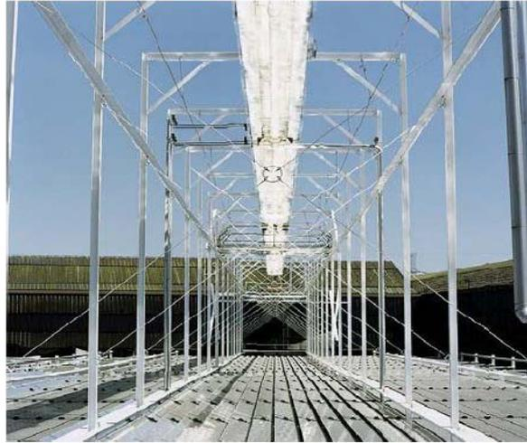
Fig.1.35 Prototype d'un concentrateur cylindro-parabolique à miroirs de Fresnel réalisé par Solarmundo [40]
