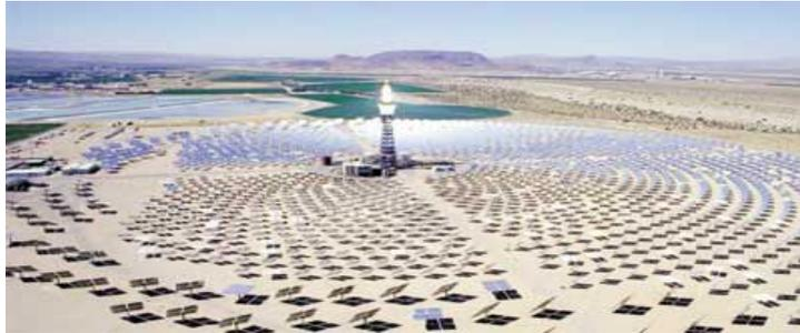
Fig.1.22 Vue d'ensemble de la centrale Solar 2 de 35.5 MW avec 1926 héliostats [37]
