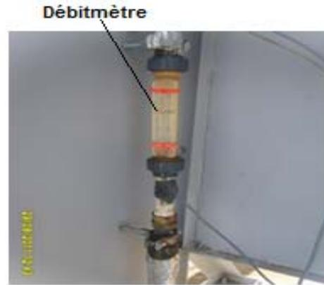
Fig. 3.2.16.h mesure du débit du fluide caloporteur
