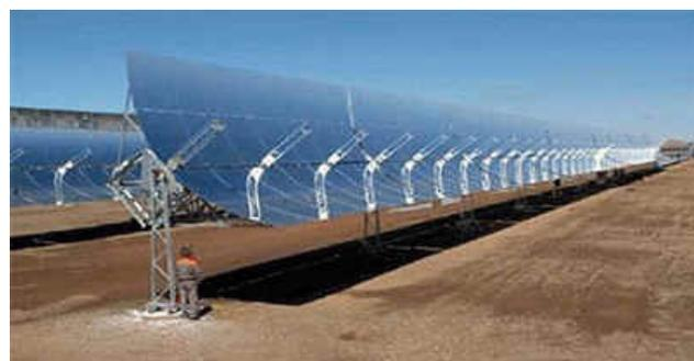
Fig.1.16.b Concentrateurs cylindro-paraboliques utilisés dans la centrale ANDASOL
