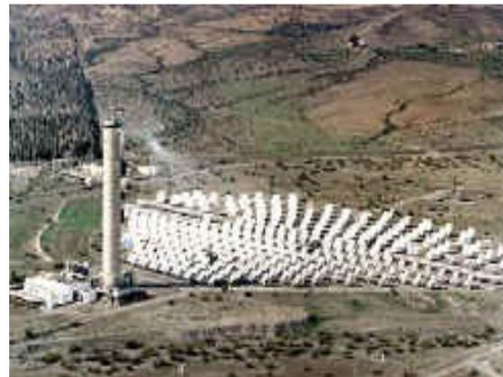
Fig. 1.21 Centrale solaire à tour CESA 1 sur la plateforme solaire d'Almeria (Espagne) [37]
