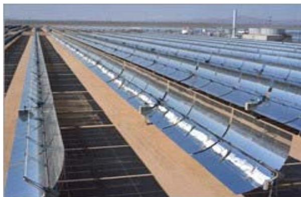
Fig.1.18 Champ du système cylindro- parabolique installé sur le site de Hassi R'mel [34]
