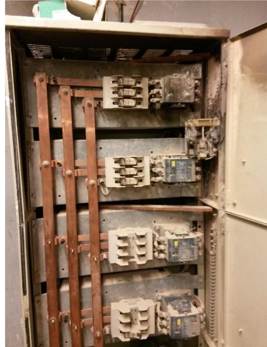
Figure 49 : Photographies montrant l'incendie ayant eu lieu sur les batteries de condensateurs
