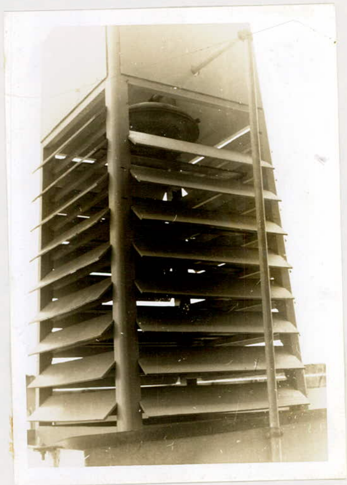
-Tour de refroidissement-
