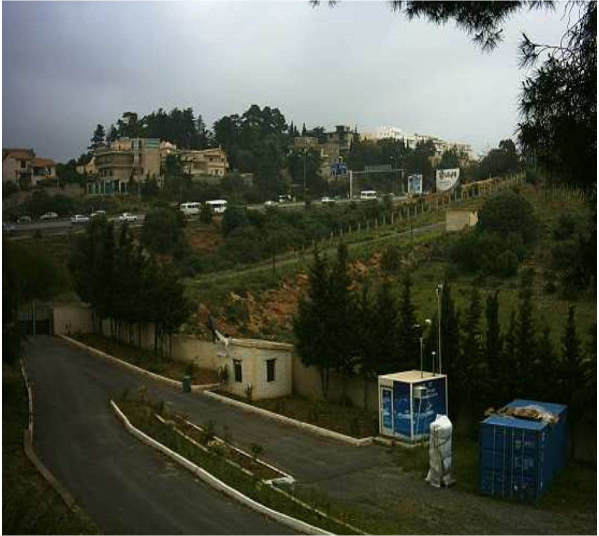
Photo n°2 : Station de mesure de Ben Aknoun et vue sur la rocade sud
