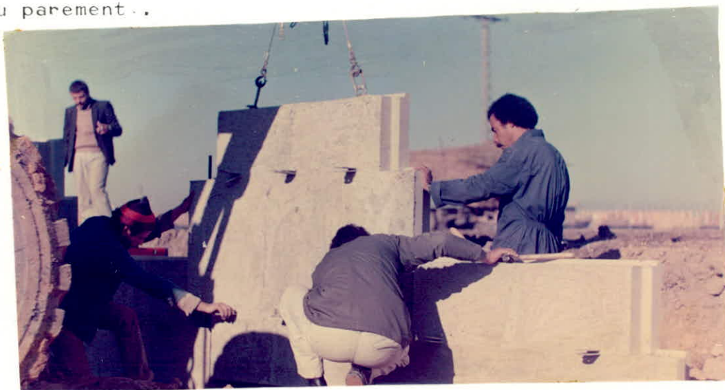
mise en place d'une écaille entière
