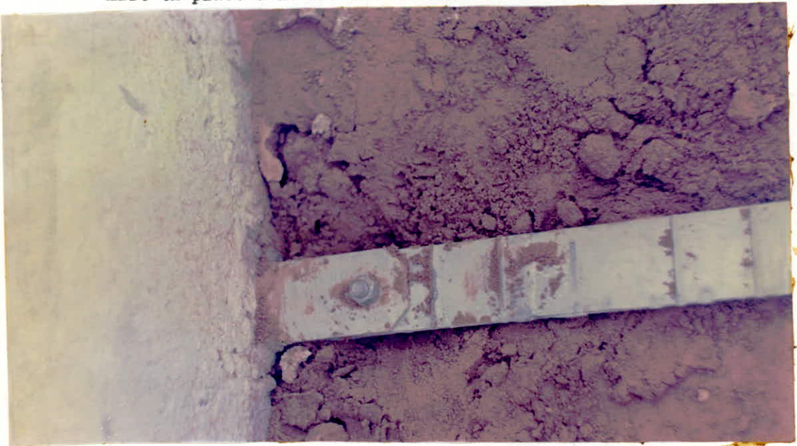
mise en place d'un lit d'armatures
