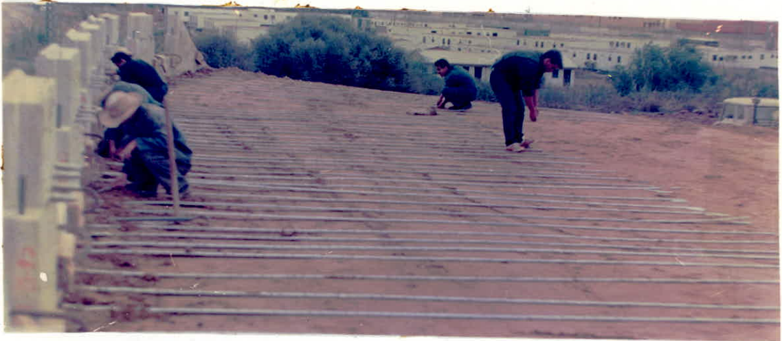
mise en place d'un lit d'armatures
