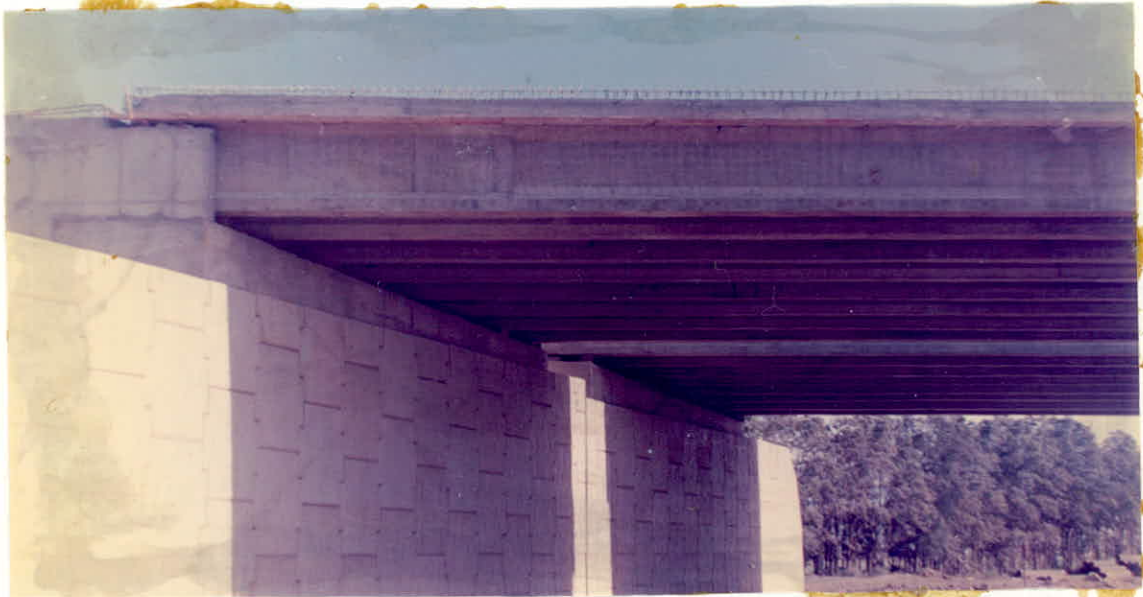
mise en place des poutres
