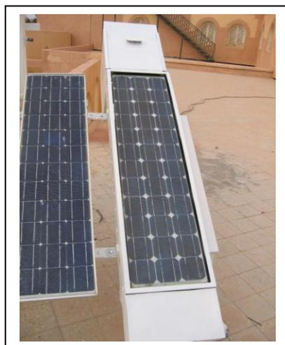
Figure 4.19 : Capteur hybride PVT à air à coté du module photovoltaïque libre sur une même structure
