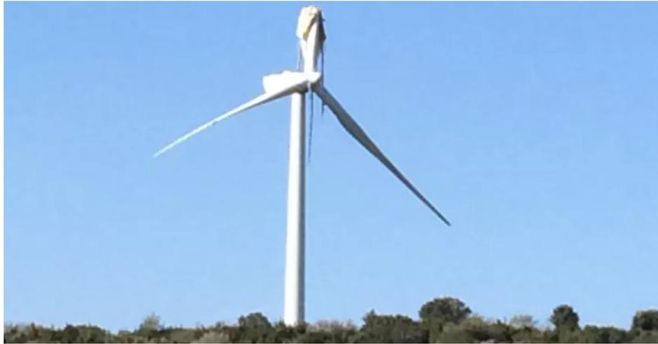
**Figure 4.3** – Pale d'éolienne détruite par la foudre lors d'un orage en France (Avril 2018) [150]
