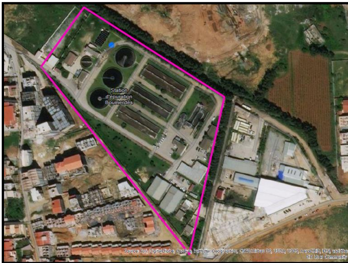
Figure 2 : La station d'épuration de Boumerdès
