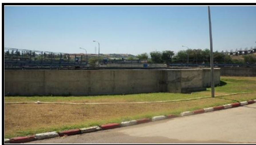
Bassin de clarification
