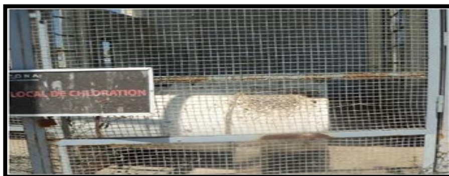
Local de chloration
