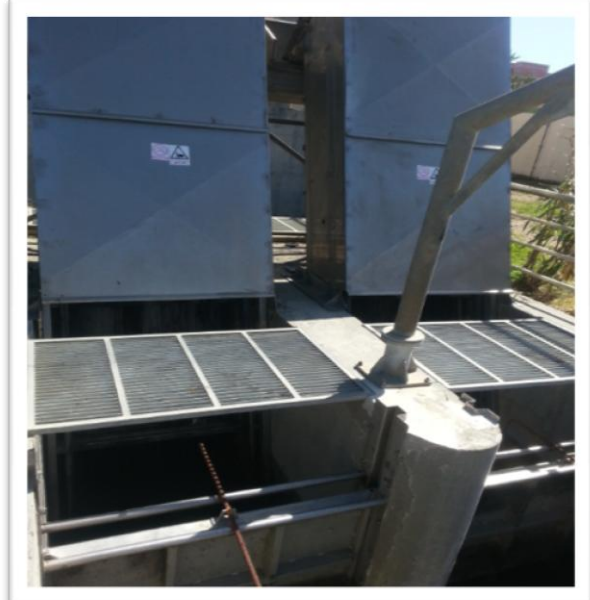
Figure IV.8 : Dégrilleur fin.[9]
