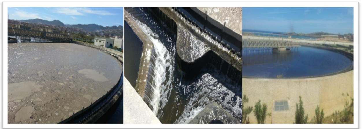
Figure IV.12 : Décanteur secondaire.
