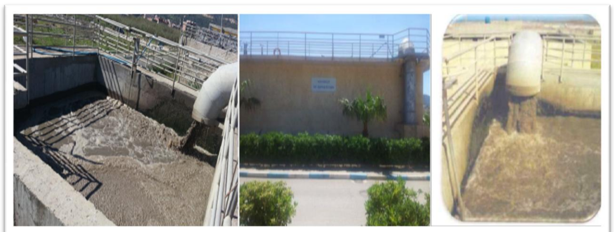
Figure IV.10 : Ouvrage de répartition (puits de contact).[9]
