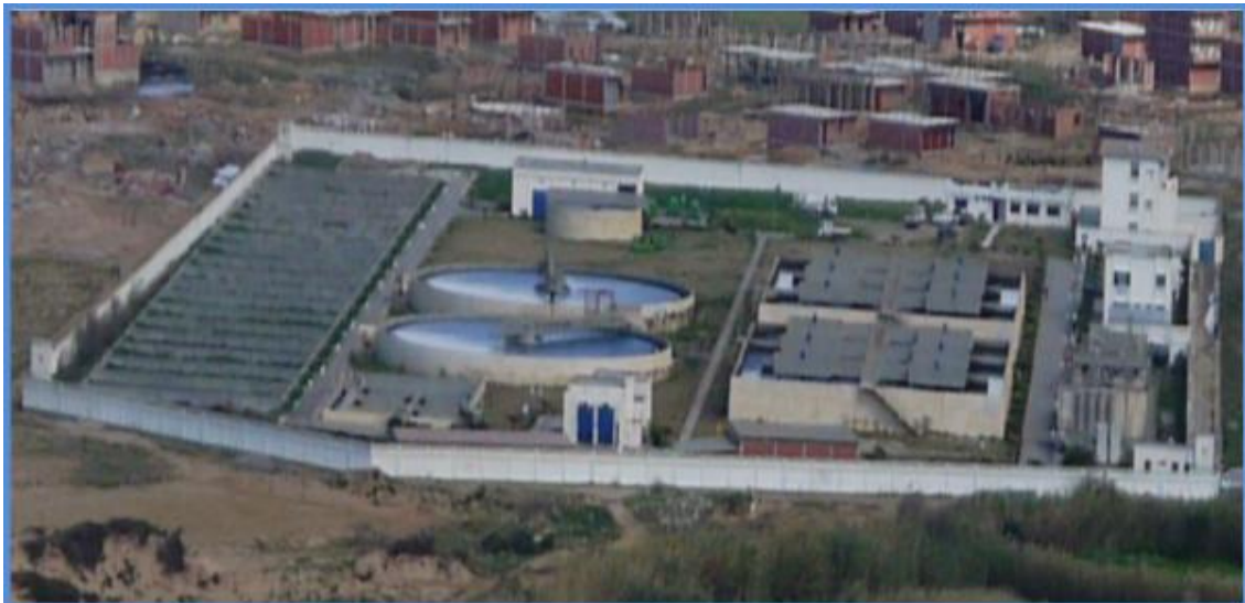
Figure IV.2 : Photo aérienne de la STEP de Jijel.
