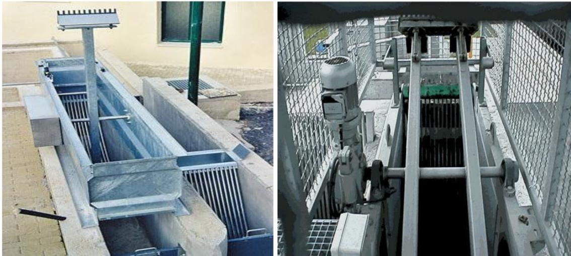
Figure 3.2 *dégrilleur vertical (vue de biais et de face)*
