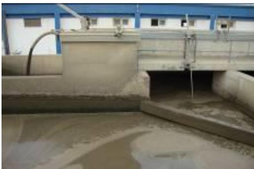
**Figure 0.14** Alimentation de la bache des boues stabilisée par un déversoir mobile
