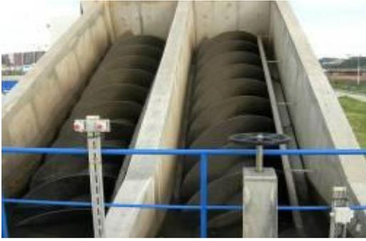
**Figure 0.17** *Vis de recirculation*
