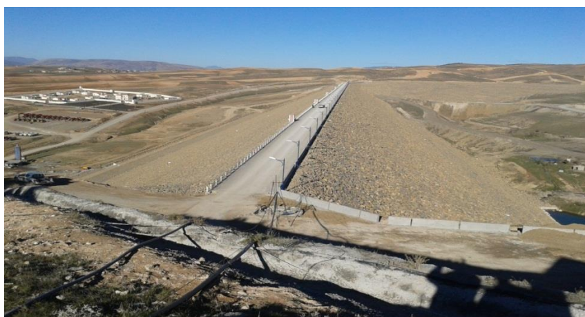
Figure I-2 : Barrage de Draa Diss
