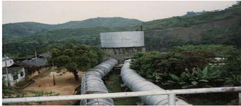
Figure VII-5 : Cheminée d'équilibre d'un circuit d'irrigation, Cimelta, Madagascar
