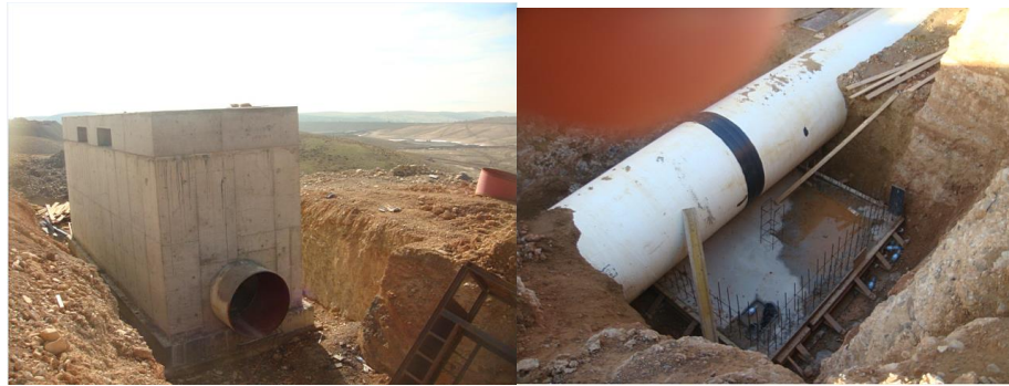
Figure VIII-5 : construction des regards
