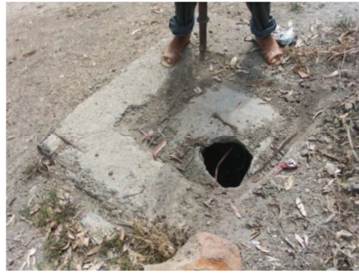
Photo II.04: Regard d'ouverture impossible.
