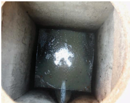
Photo II.05 : Regard en bon état.
