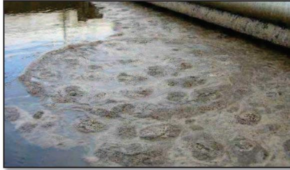
Figure V.1: Déchets graisseux de l'épuration
