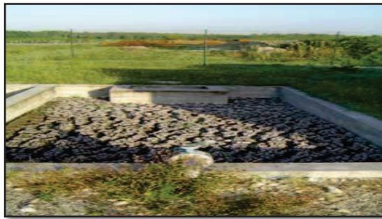
**Figure V.6 : Lit de séchage des boues**
