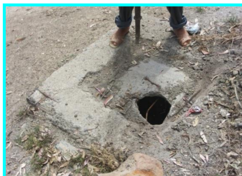
Photo III.07 : Regard impossible d'ouverture.
