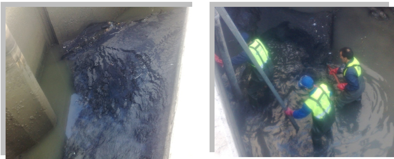
Figure 34 - Hydro-curage du canal amont dégrillage
