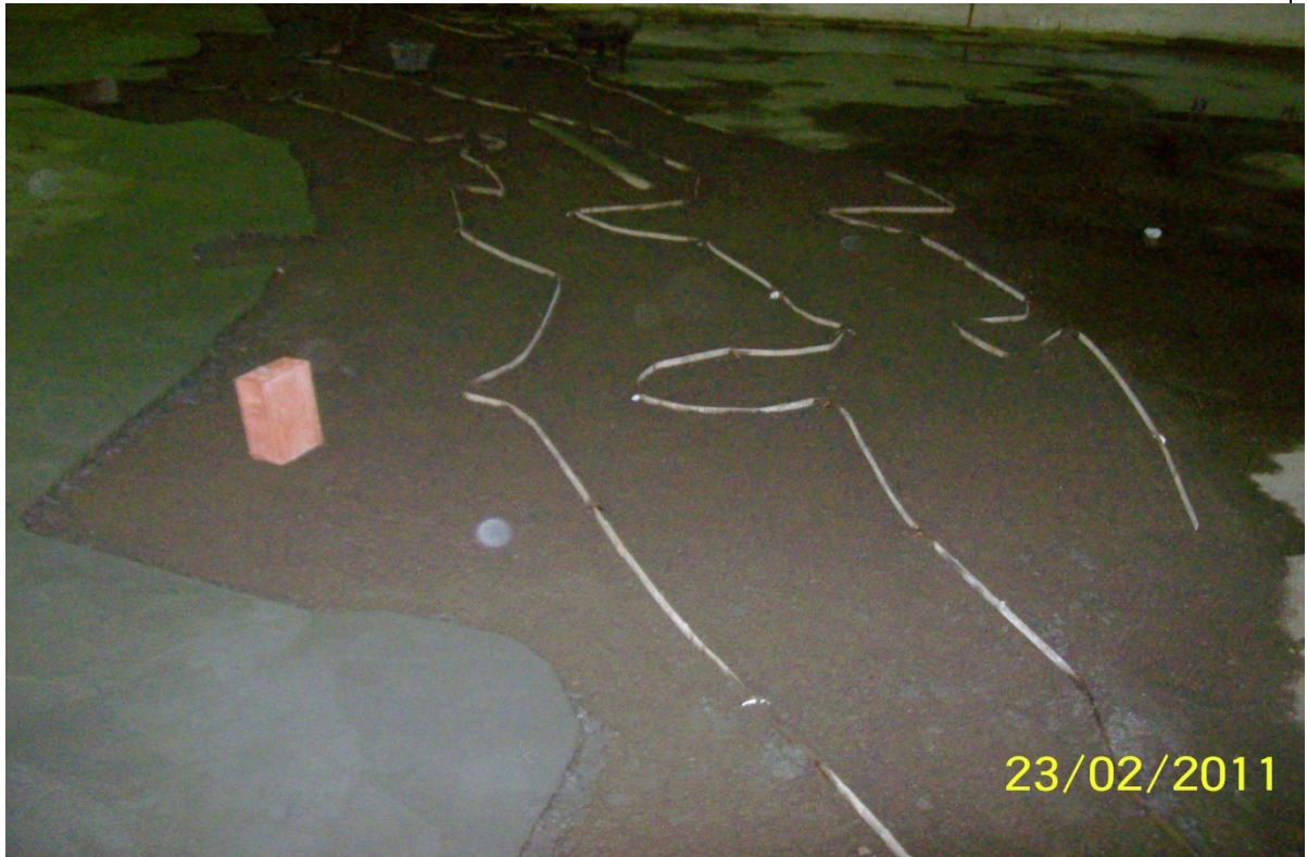
Construction des fonds fixes du bassin à houle en cours
