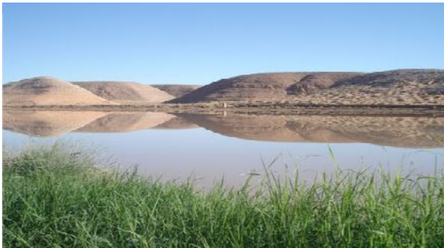
Photo II-6 : Retenue de barrage Bouchène (Projet DELTA, 2004)
