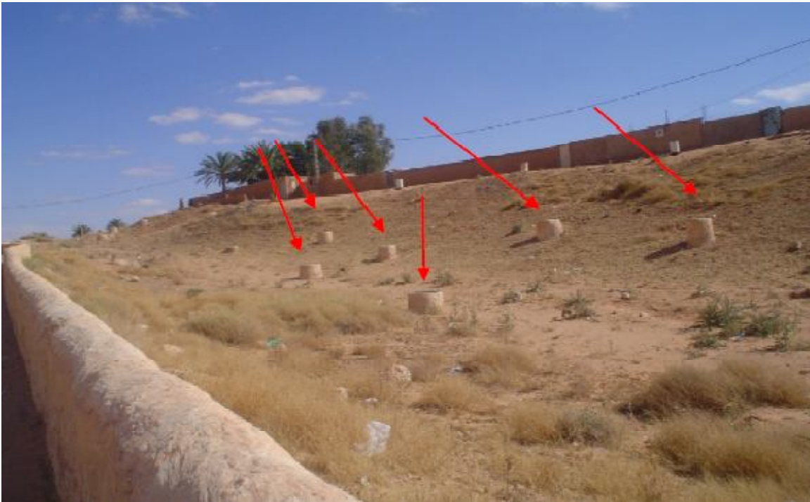
Photo II-9 : Puits d'aération
