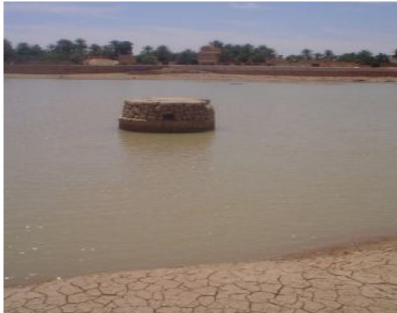
Photo II-7 : Puits capteur dans la retenue de barrage Bouchène
