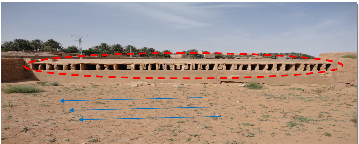
Photo III-5 : Déversoir du troisième point de régulation du canal de Bouchemdjene
