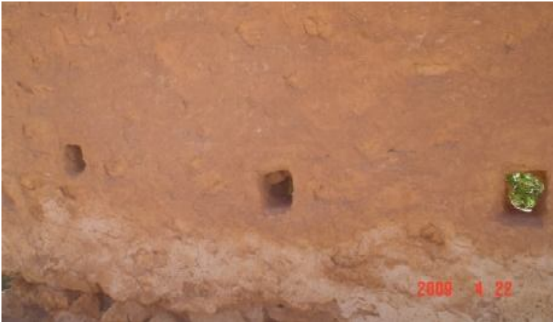
Photo II-13 : Trop-plein d'un jardin
