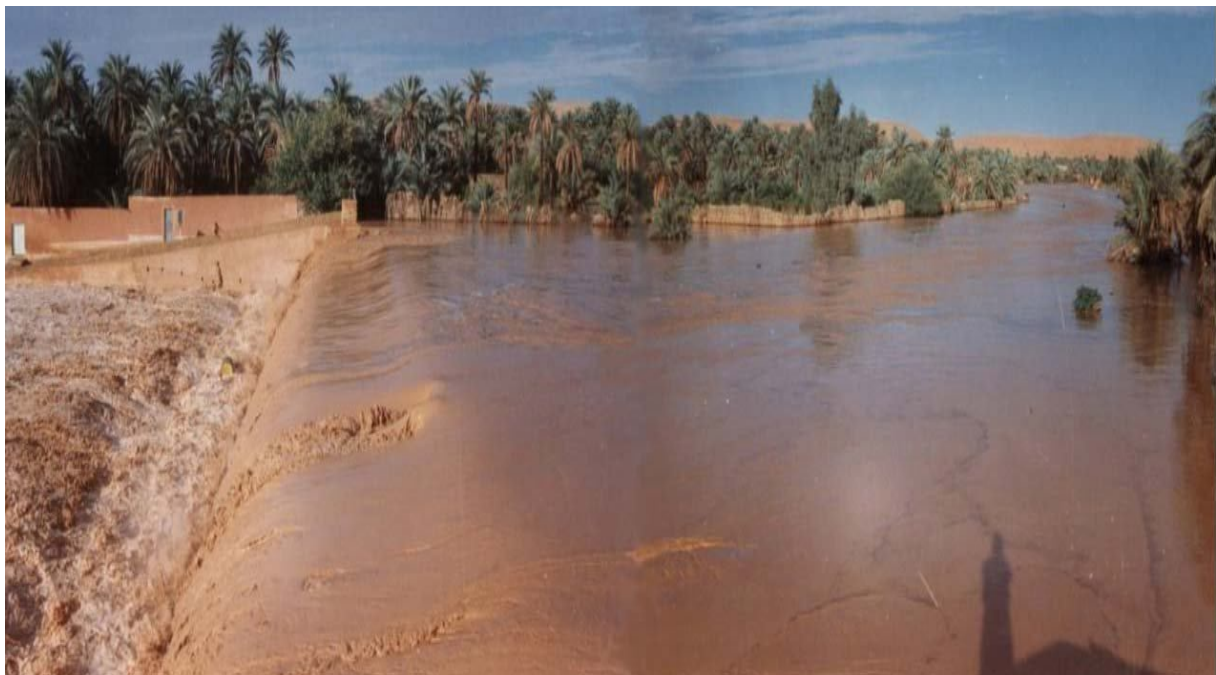
Photo II-14 : Digue de « Ahbas Ajdid »
