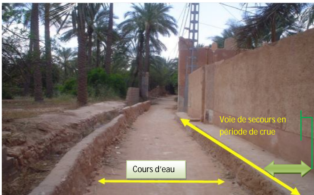
Photo II-11 : Canal à ciel ouvert
