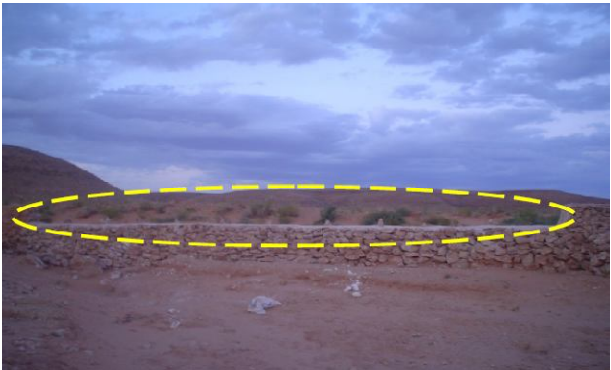
Photo II-3 : Déversoir de canal de Bouchémdjene vers le canal de Bouchène
