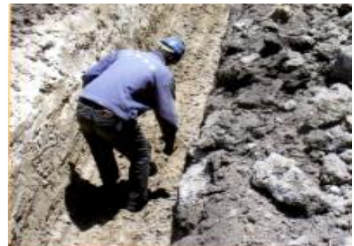
Figure V.2.Opération de revêtement
