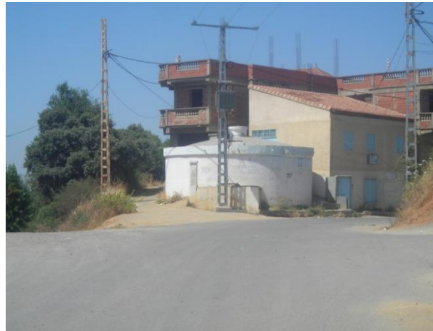
Figure III-12 : Réservoir 200 m 3 Sidi Messaoud
