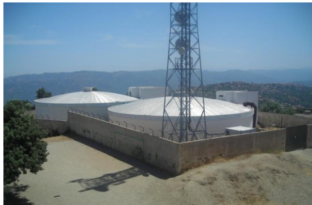
Figure III-1: Deux réservoirs 2 X 1000 m 3 de Djouad
