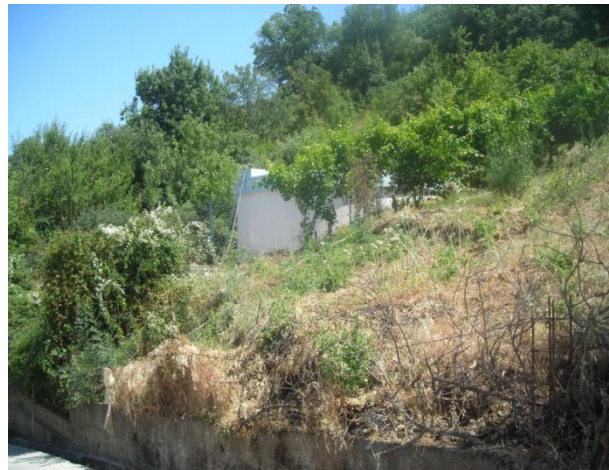
Figure III-10 : Réservoir 200 m 3 Ait Ali Ouali
