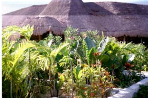
WWG pour le Restaurant Xpu-Ha Eco-Park traitant les eaux usées de 1500 personnes.
