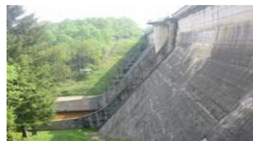
Figure 1.2 : Barrage de Vassivière
