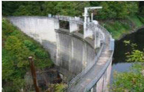
Figure 1.4 : Barrage de Luzège
