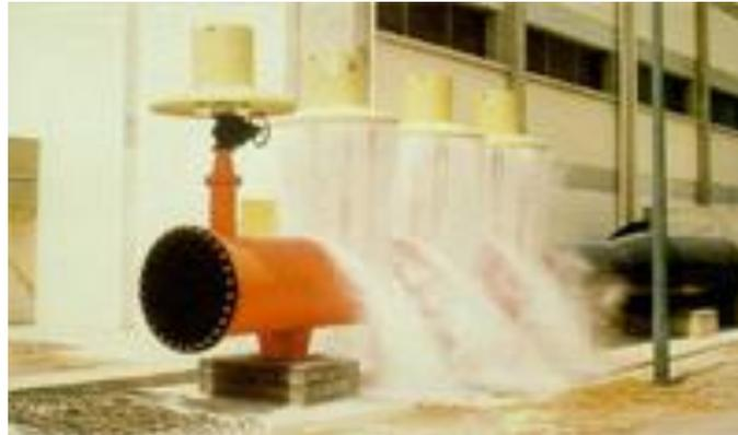
**Figure 31 :** *Soupapes de décharge en fonctionnement [photo KSB]*
