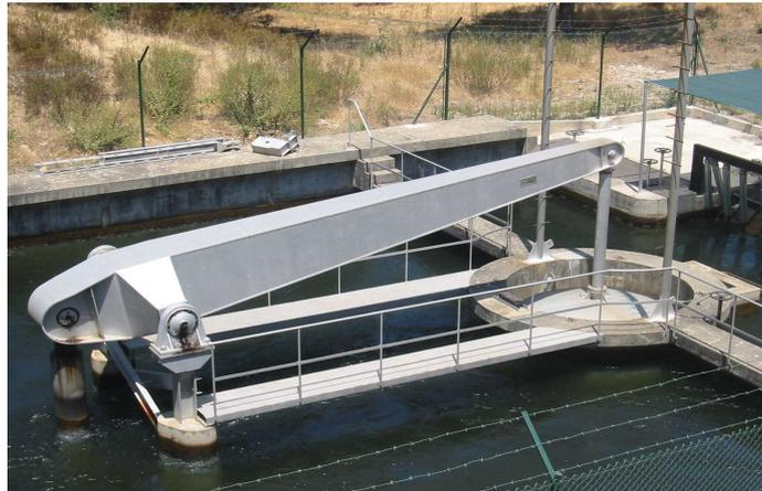
Disposé sur un jet d'eau le disque se centre et reste en équilibre même sans guidage latéral. Par l'intermédiaire d'un palonnier, le disque est actionné par un flotteur cylindrique d'axe vertical se déplaçant dans un bac communiquant avec le bassin de restitution.
