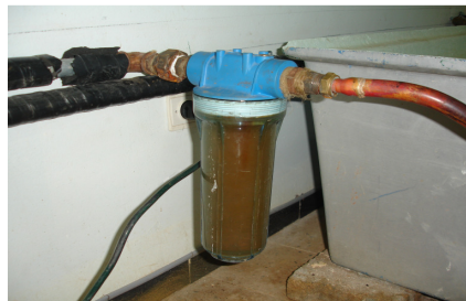
Figure 4.8 : Le filtre a eau
