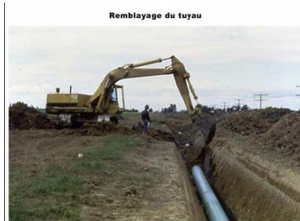
Figure I.5 : remblayage du tuyau
