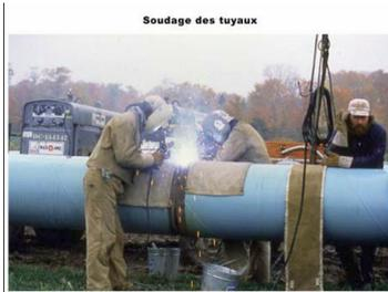
Figure I.3: soudage des tuyaux
