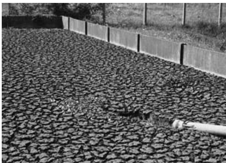
Figure 4: la technique des lits de séchage
