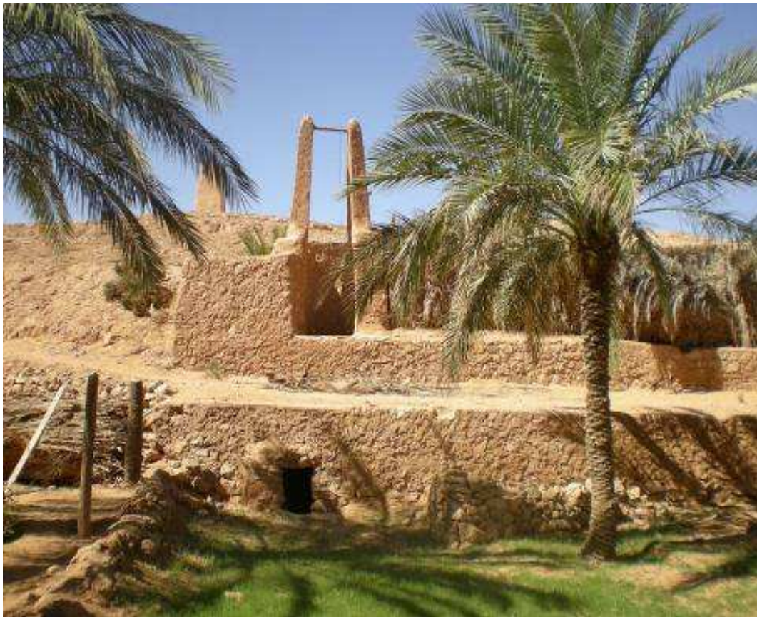
Photo II.3 : Puits capteur d'eau servant à la recharge de la nappe en période de crue.
