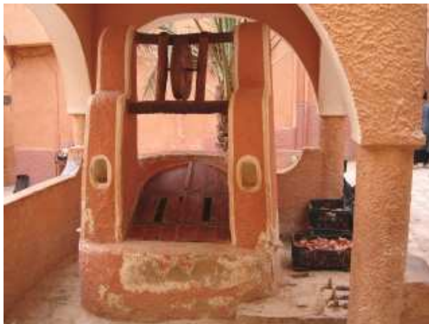
Figure II.7 : Puits captant l'aquifère Turonien dans le Ksar de Ghardaïa.
