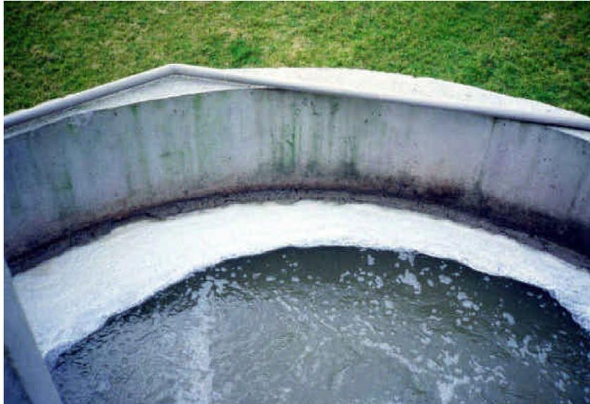
Figure II.2 : Flottation des graisses par injection de fines bulles
