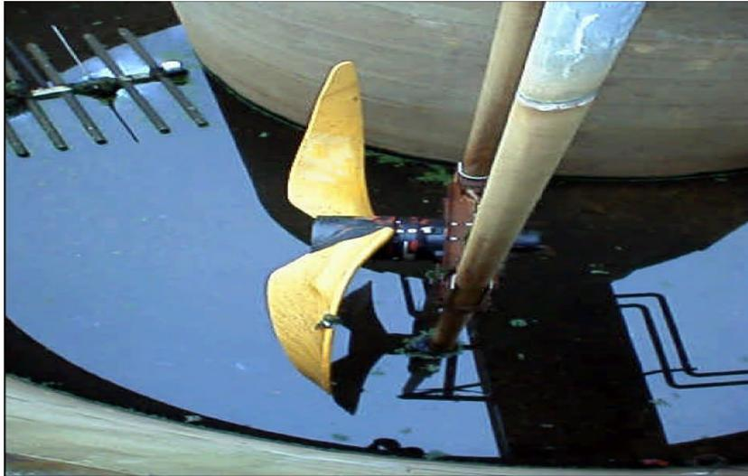
Figure II.6 : Aération et brassage séparé dans un bassin d'aération
