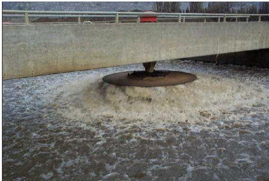
**Figure II.5 :** Turbine de surface à vitesse lente
