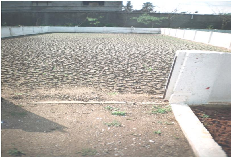
**Photo III-7 (b):** Lit de séchage (boue séchée)
