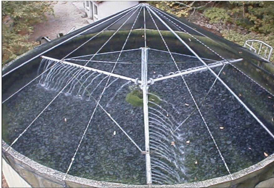
**Figure II.7** : Lit bactérien avec garnissage traditionnel
