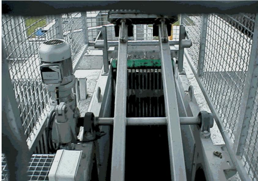
Figure II.1 : Dégrilleur courbe
