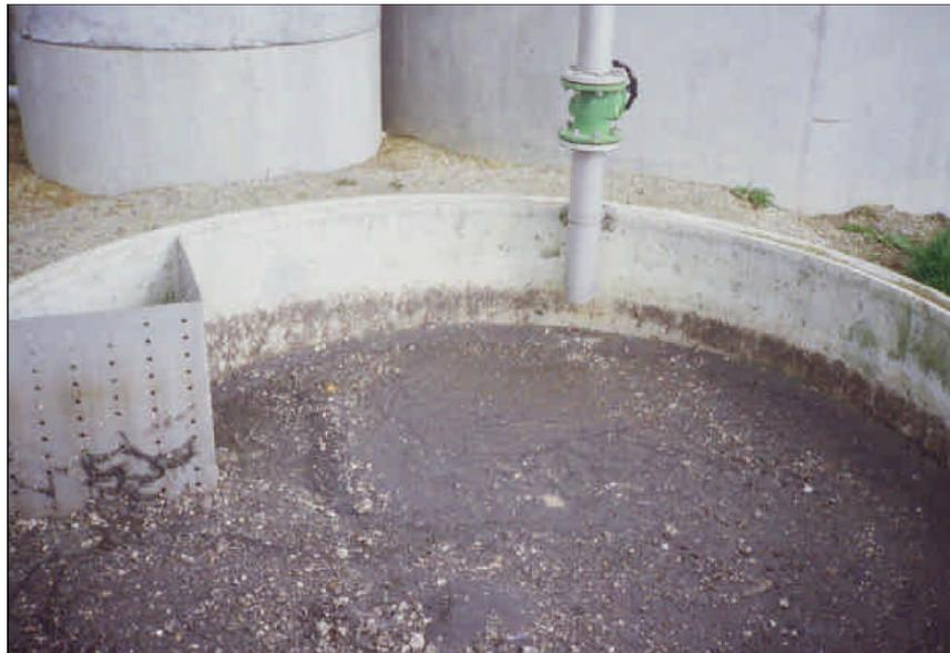
Figure II.3 : Extraction du sable d'un dessableur-dégraisseur
