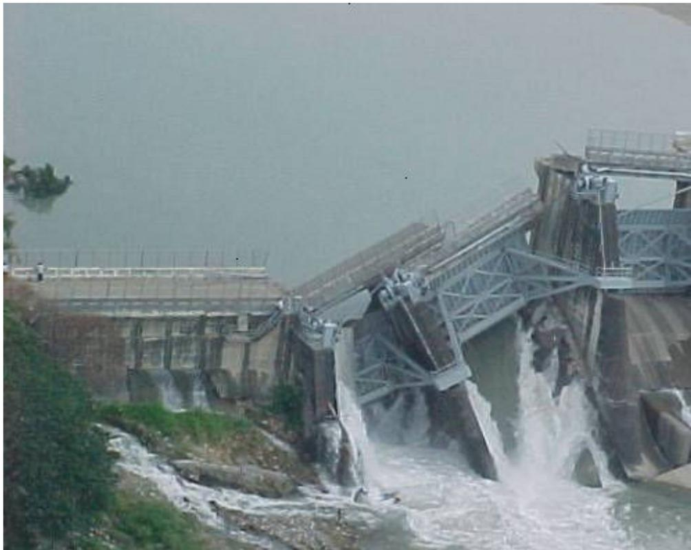
Figure II-1 : rupture d'un barrage en béton
