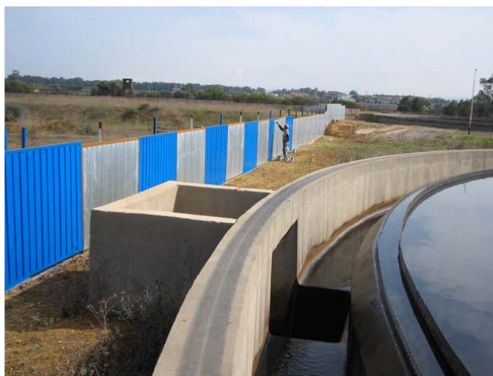
Photo 1 - point d'échantillonnage des eaux à la sortie du décanteur primaire
