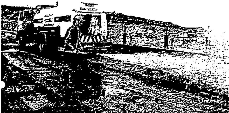
**Photo 8: Nettoyage à l'eau sous pression**
