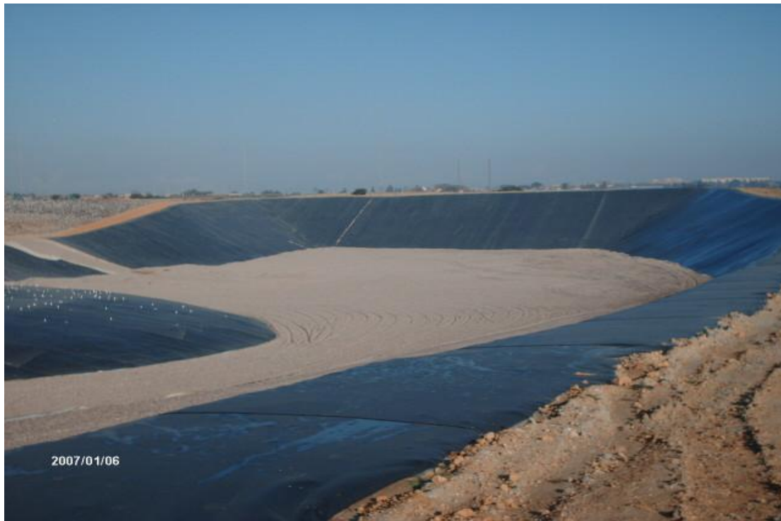
Figure V-2: L'état de la Décharge après 2002.
