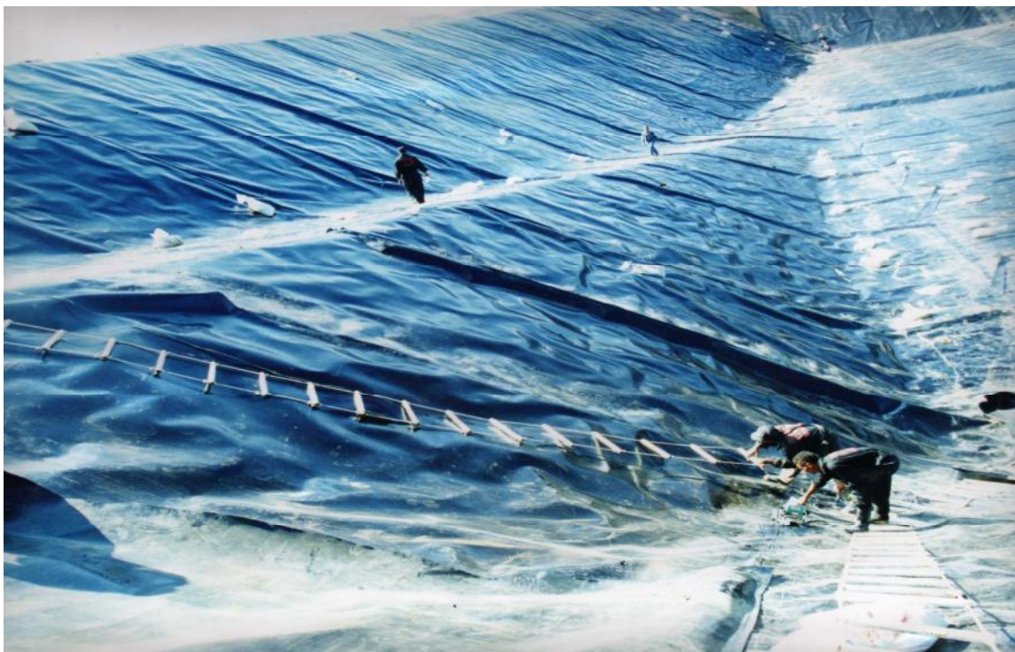
Figure V-8 : mise et soudure de la Géomembrane.
