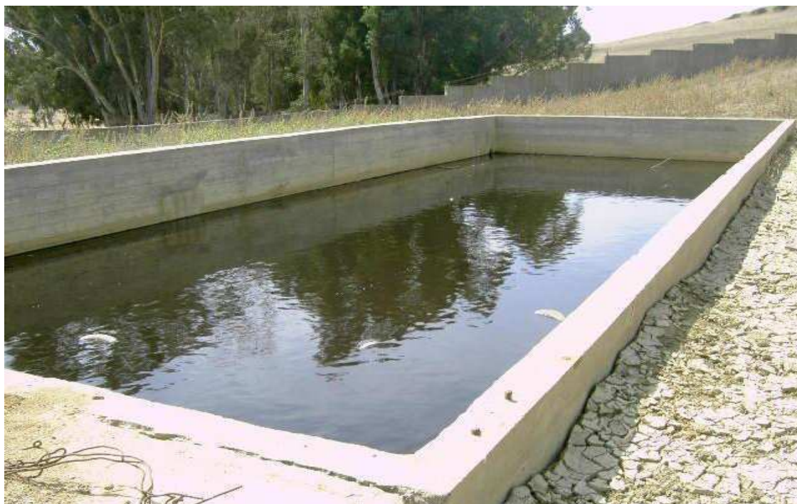
Fig VI.7 Bassin de décantation
