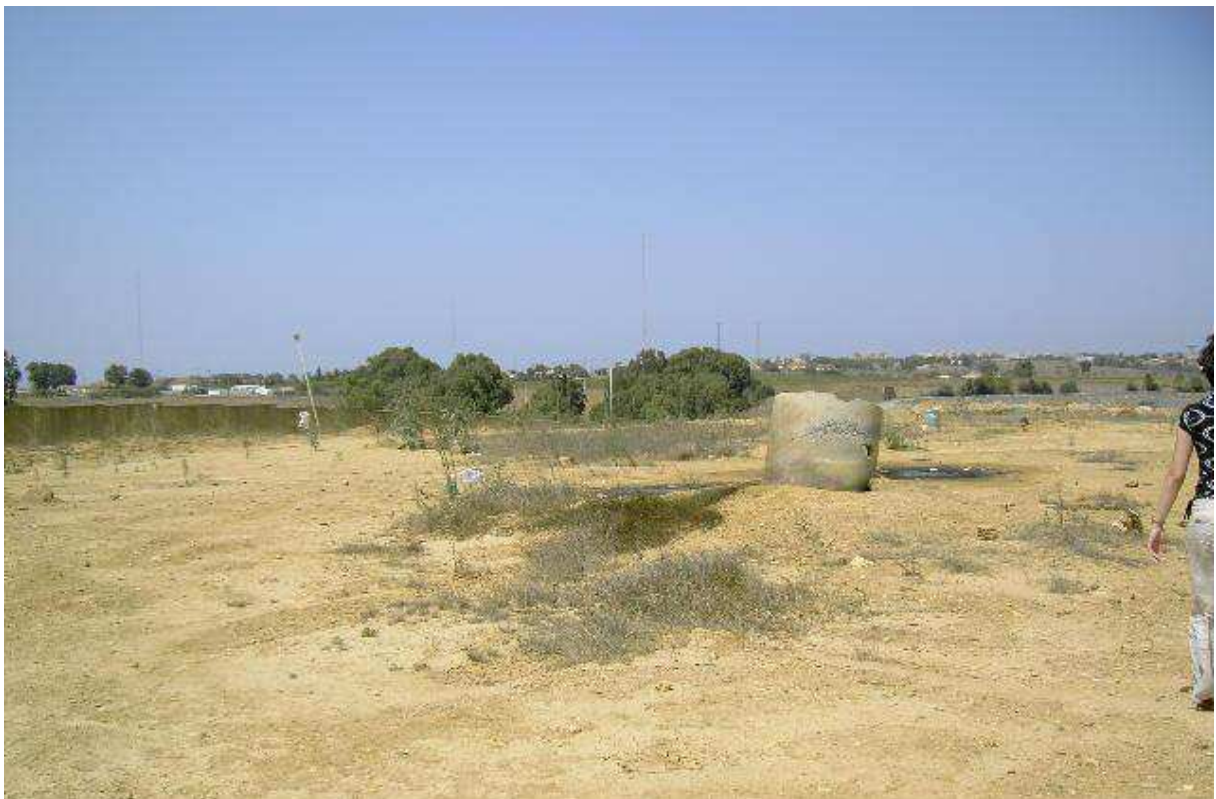
Fig VI-5 Buse d'évacuation du biogaz
