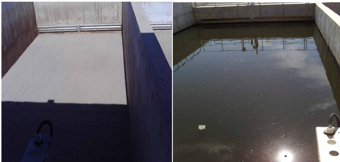
Figure 12 : Filtre à sable, à droite remplie d'eau, et à gauche vide.
