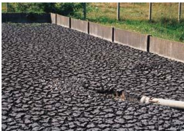
Figure 6 : La technique des lits de séchage
