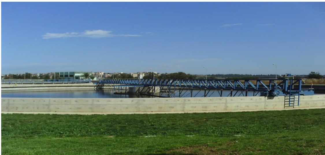
Figure 11 : Un des deux clarificateurs
