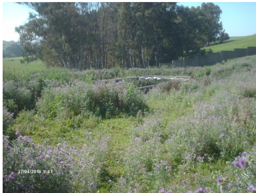
Figure II-4 : Vue du bassin de collection des lixiviats du casier 5 au point de prélèvement P_3
