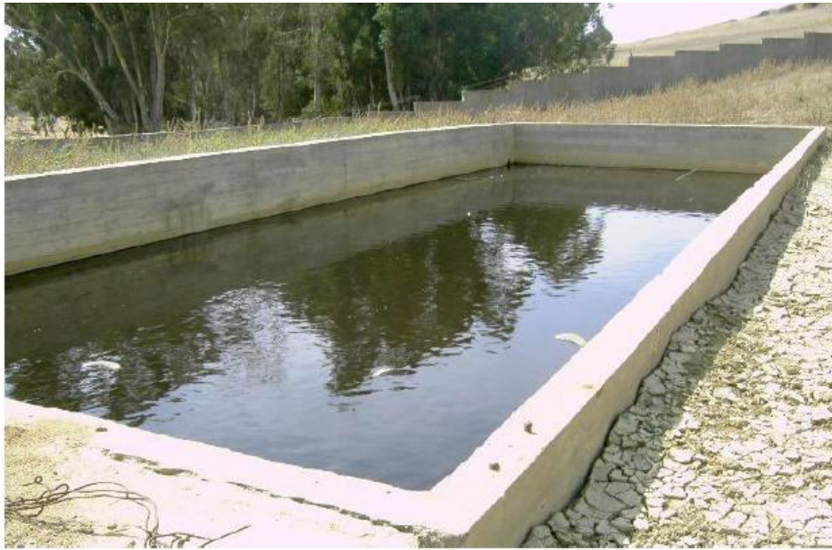
Figure VI-17 : Le bassin de décantation de lixiviats.
