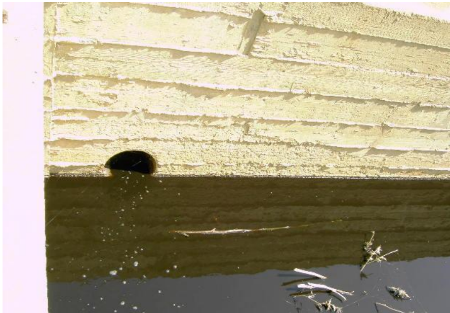
Figure VI-18 : Canal de réception de lixiviats
