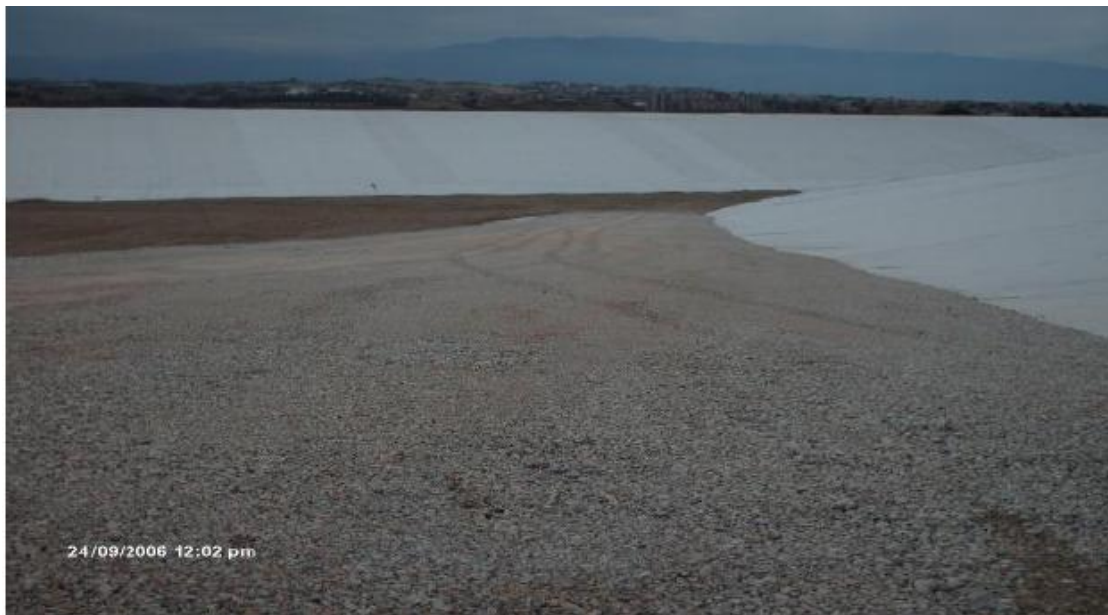
Figure VI-14 : la couche de gravier.
