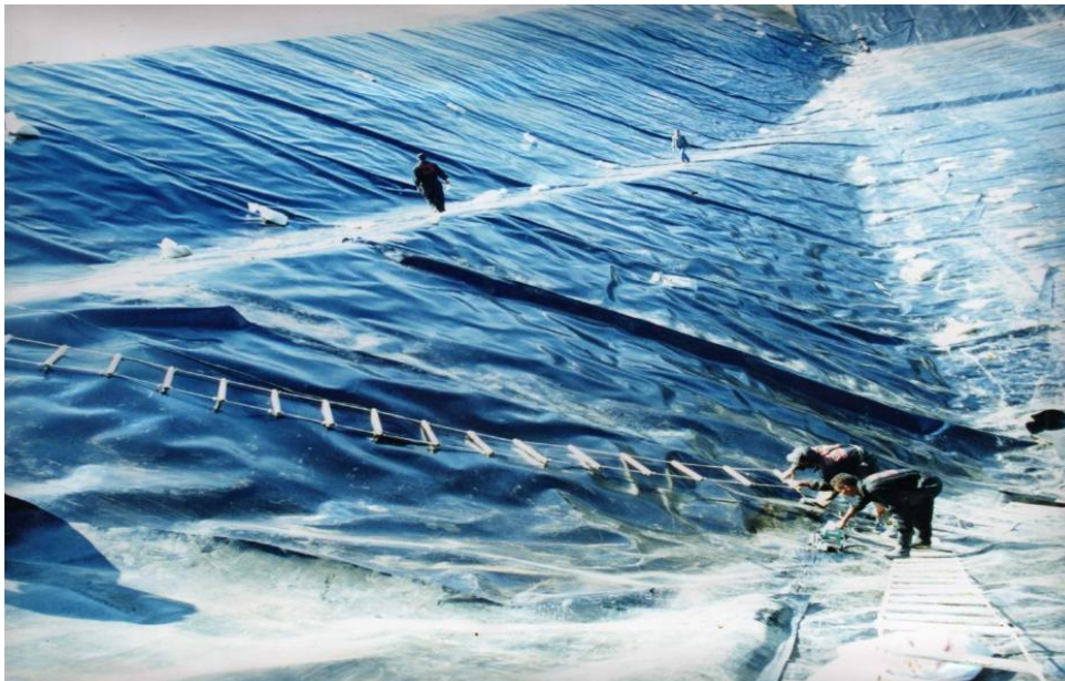
Figure VI-10 : mise et soudure de la Géomembrane.
