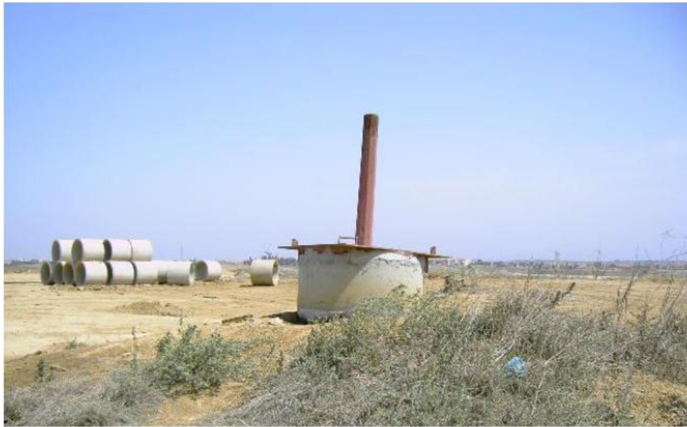
Figure VI-15 : Système de récupération de BIOGAZ sans traitement, Ouled Fayet
