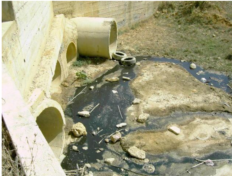
Figure VI-19 : Canal d'évacuation de lixiviats vers l'Oued Ben Brahem.
