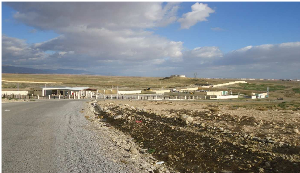
figureIV .1 : Centre d'enfouissement technique de M'sila (l'Entrée)
