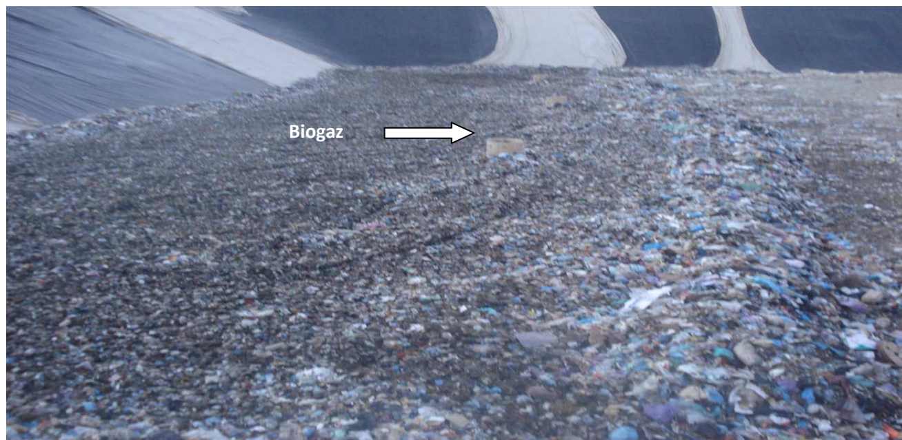
figureIV .1 e: Centre d'enfouissement technique de M'sila (déchets après compactage avec vue sur la buse de sortie du biogaz)
