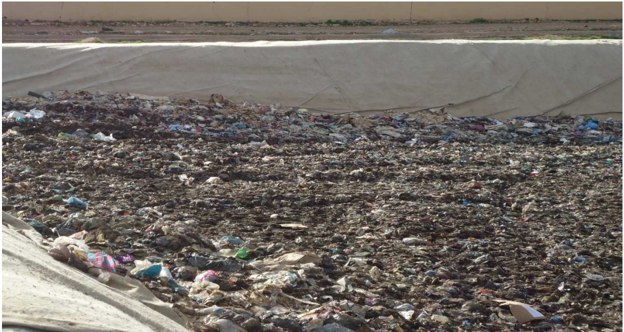
figureIV .1f : Centre d'enfouissement technique de M'sila (étanchéité par géomembrane et géotextile)
