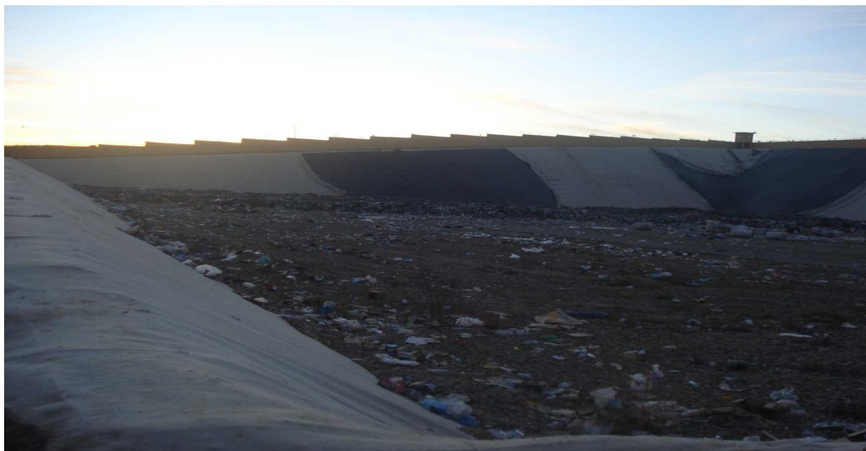
figureIV .3: Centre d'enfouissement technique de M'sila (vue d'un casier avec couverture des déchets)
