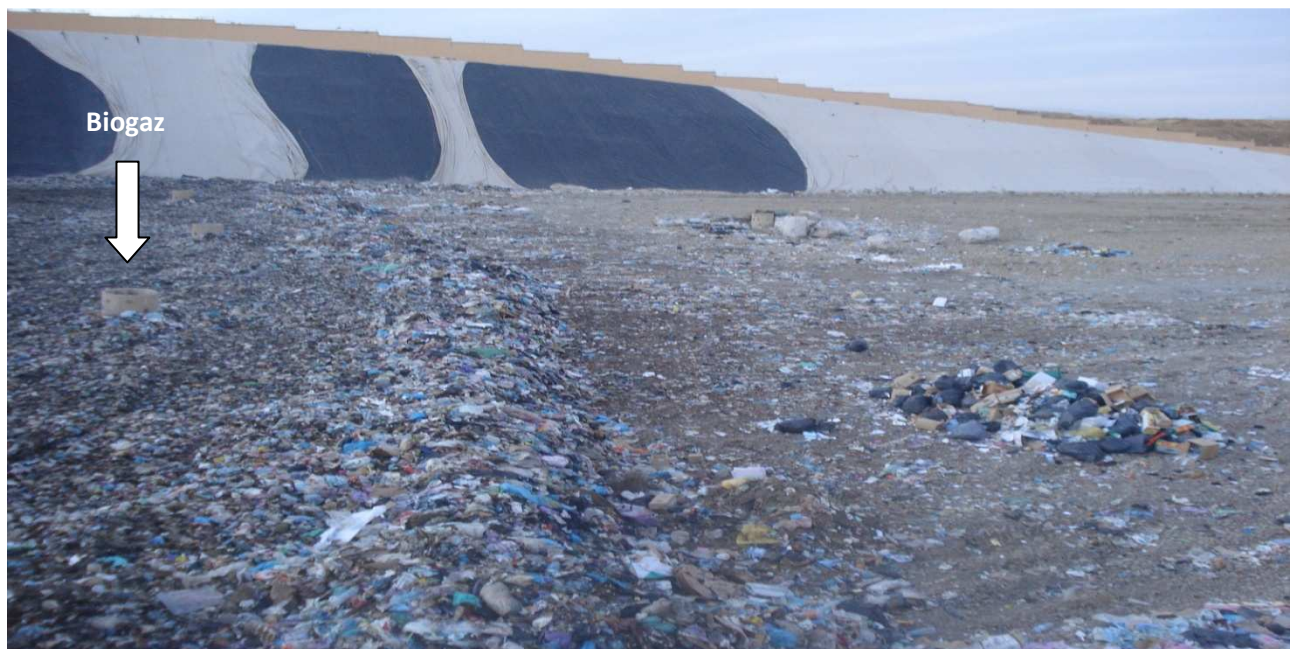
figureIV .2: Centre d'enfouissement technique de M'sila(les déchets après compactage)
