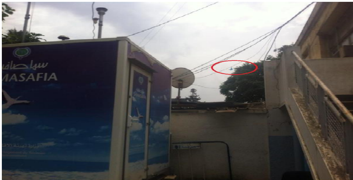
Figure n°21 : S10: Poste de prélèvement à l'hôpital CHU Mustapha Pacha d'Alger
