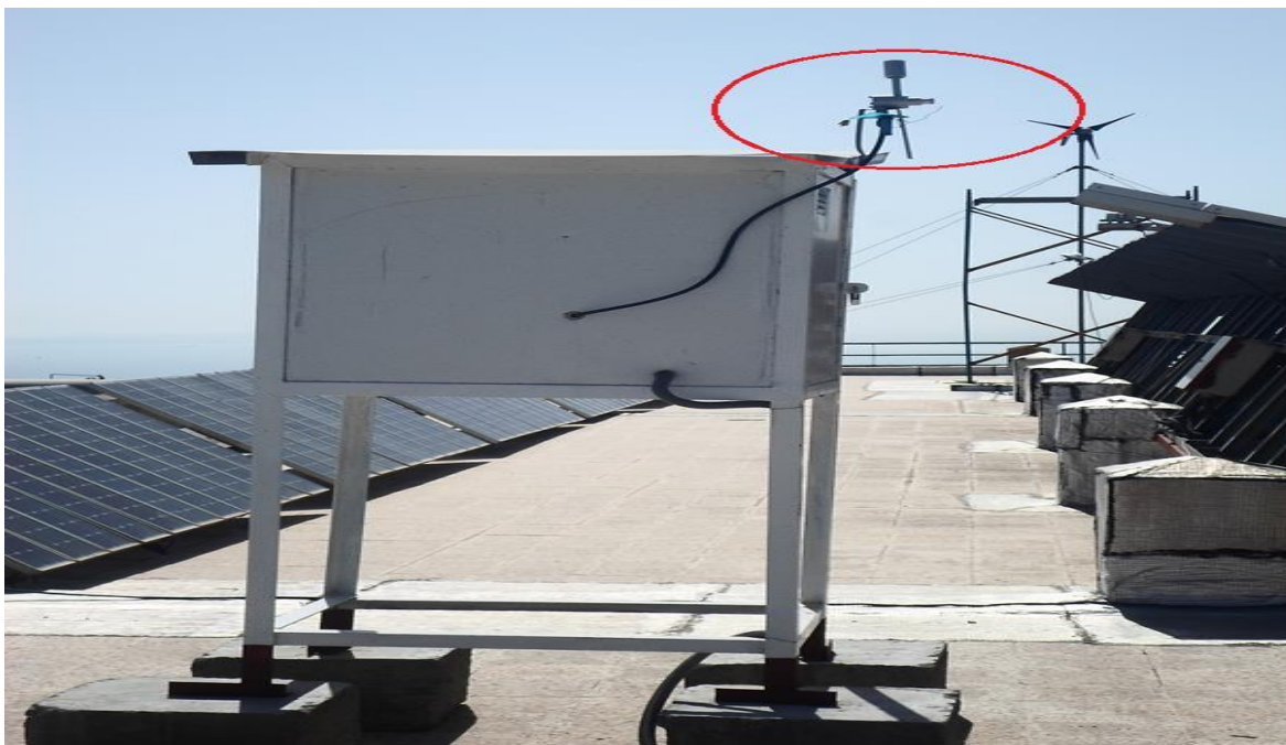
Figure n°22 : S12 : Poste de prélèvement au Centre De Développement Des Energies Renouvelables Cder “ Bouzaréah” S12 au CDER, Bouzaréah: Le tube passif est placé sur le support d'un appareil installé sur une terrasse avec une vue sur le littoral ouest d'Alger. Ce site qui est très bien ventilé n'est pas exposé aux émissions du trafic routier.
