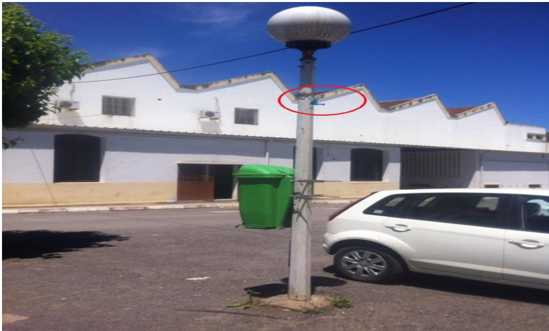
Figure n°19: S7 : Poste de prélèvement à l'école nationale polytechnique d'Alger
