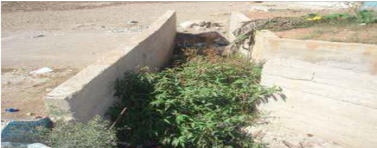
**Fig. n° 28:Collecteur des eaux pluviales (Alger Plage) ; (Eaux urbaines et pluviales).APPL**
