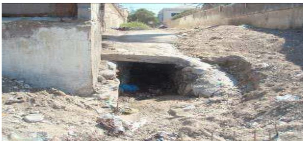
**Fig. n °27 : Collecteur des eaux pluviales (urbaine et pluviale)
