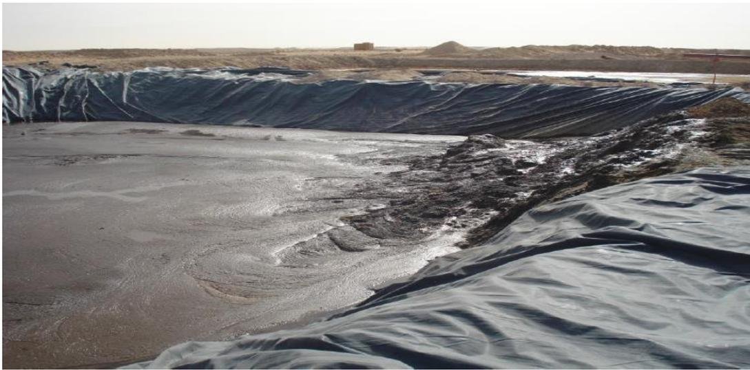
**Figure A.17** : Bourbier de forage (wet pit)
