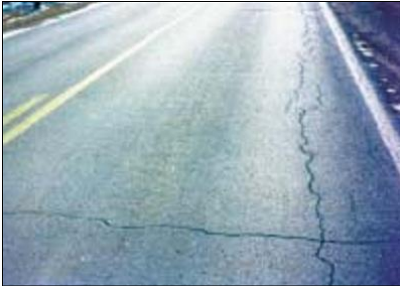
Figure I.8. Fissures latérales
