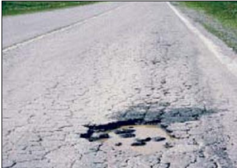
Figure I.10. Fissures sous forme de nid de poule
