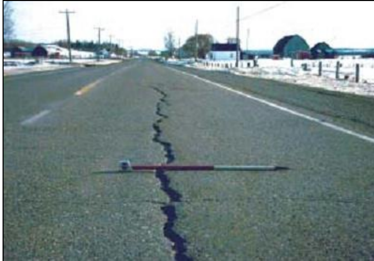
Figure I.6. Fissures longitudinales
