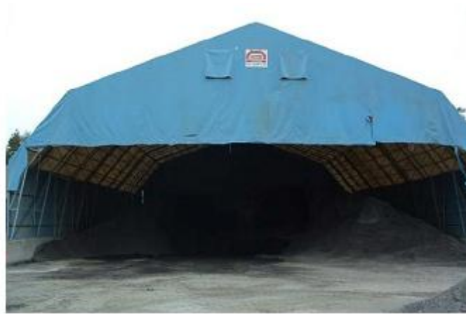
Figure III.6. Couverture des lots d'agrégats d'enrobé pour limiter humidité et ensoleillement
