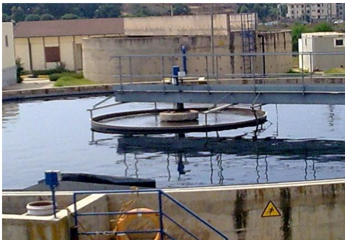
Figure I.6 : Clarificateurs de la STEP de boumerdes
