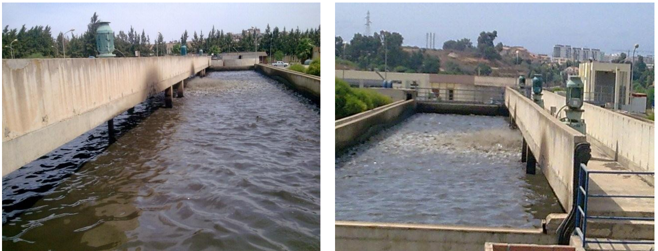
Figure I.5 : bassins d'aération de la STEP de boumerdes
