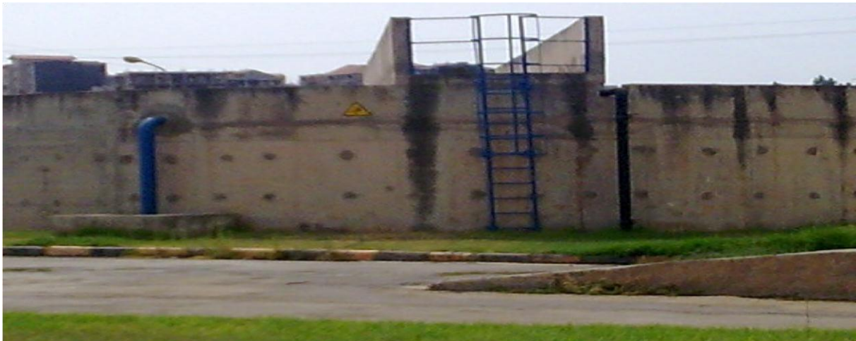
Figure I.7 : Epaississeur de la STEP de Boumerdes
