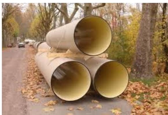
**Figure IV.1 : Canalisations en PRV**
